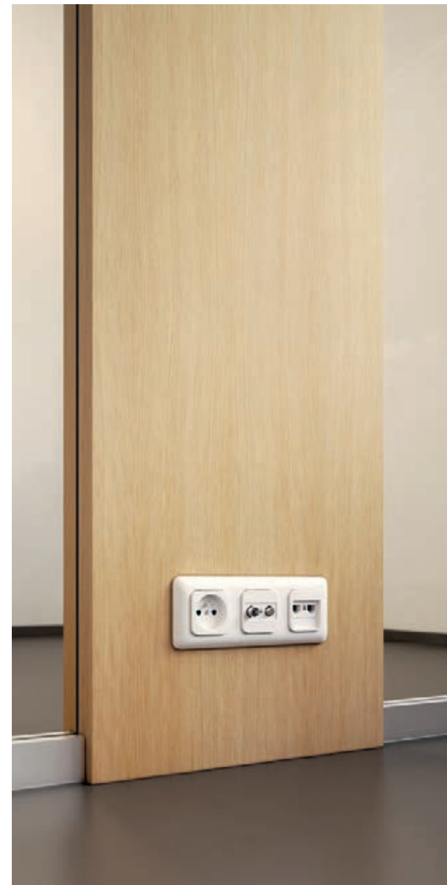
Dřevěný panel osazený rozvodem sítí
