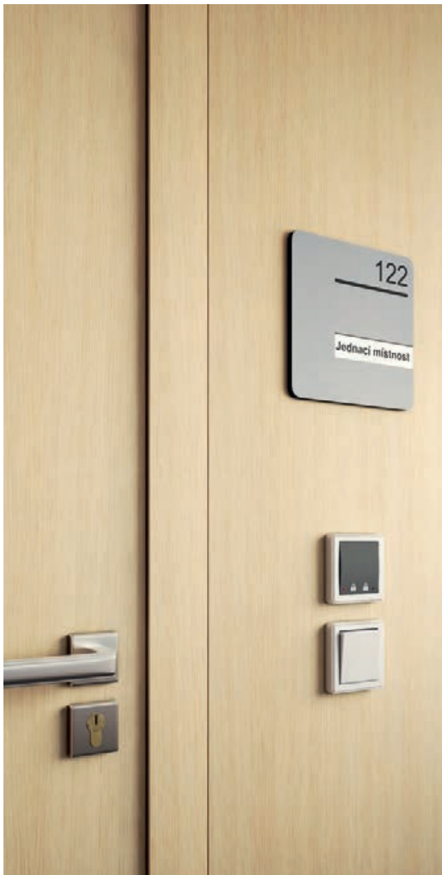
Dřevěný panel osazený vypínačem a přístupovým systémem
